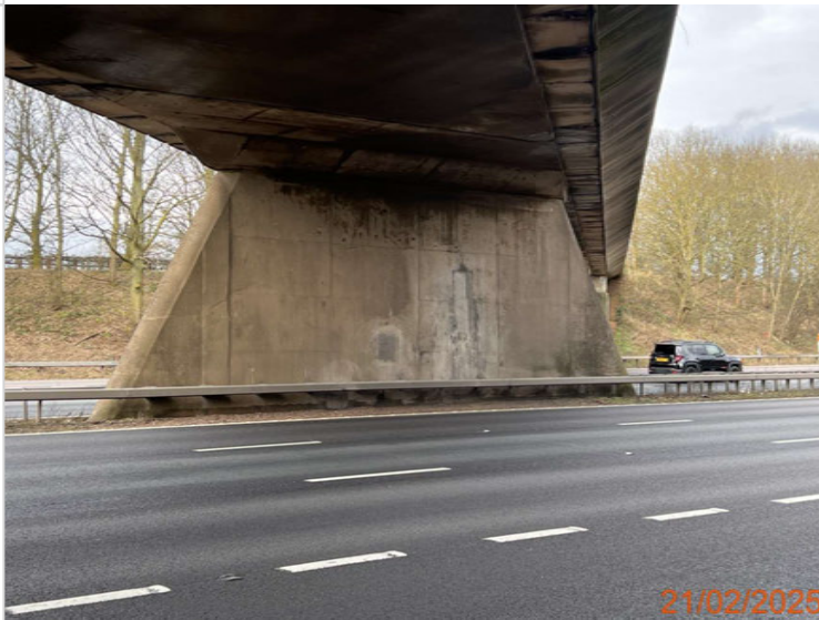
14. Centre pier - east face.JPG
