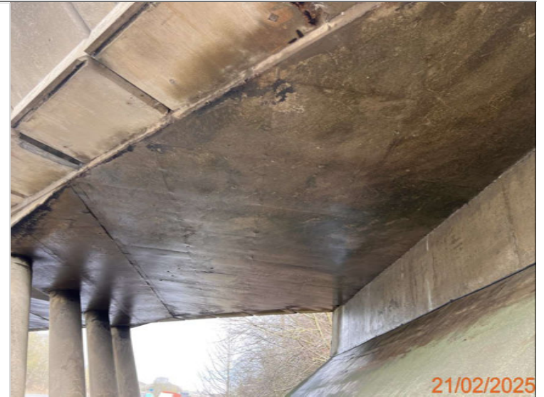
18. East span soffit.JPG
