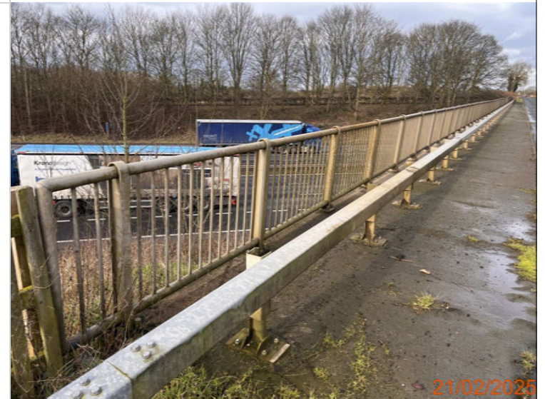
28. South parapet - east end.JPG
