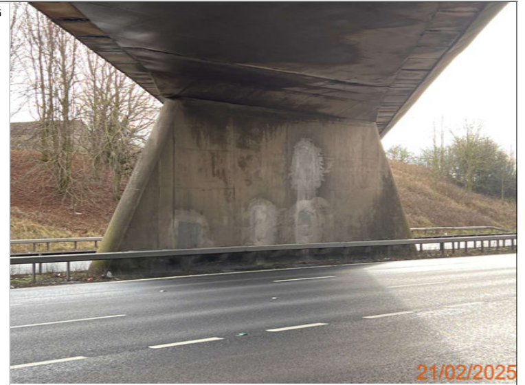
13. Centre pier - west face.JPG
