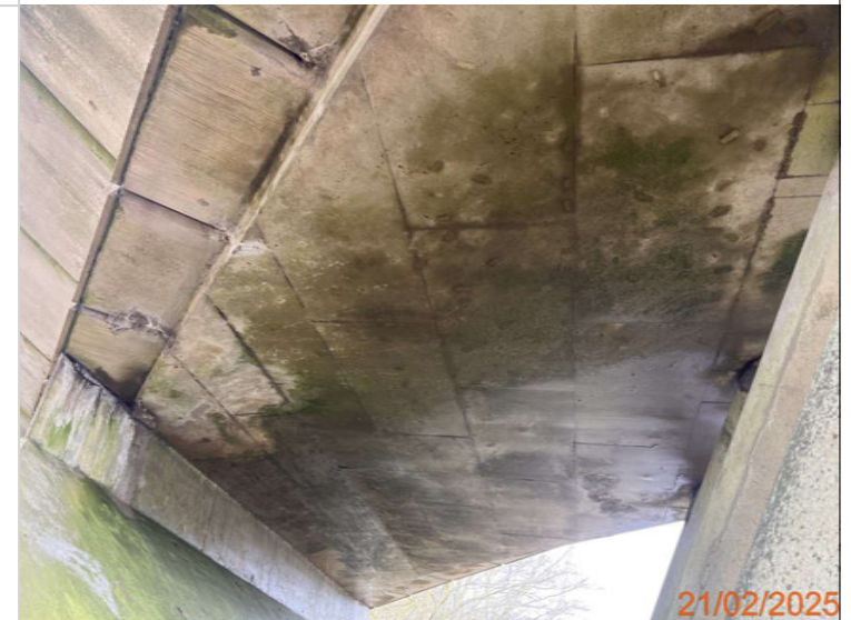
16. West span soffit.JPG
