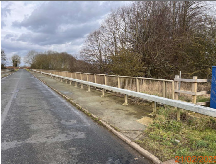
26. North parapet - east end.JPG
